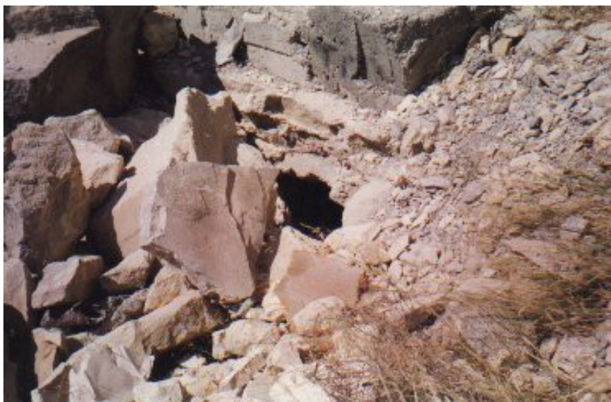
Le trou dans les éboulis. Au-dessus, le bloc de béton
